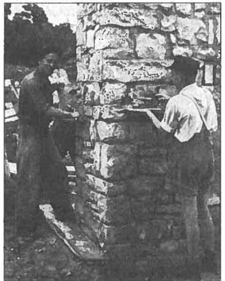
Die Steine werden verfugt
