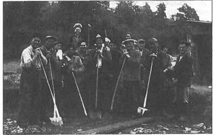
Ein Arbeitstrupp beim Ausheben des Baugrundes
