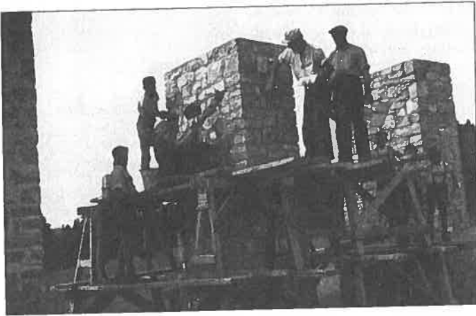
Beim Bau der Säulen
